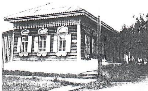
Жилой дом по ул. Ленина, 9
